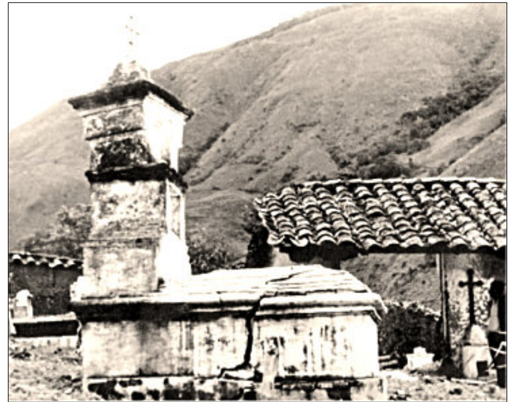
Fotografía 4. Túmulo funerario destruido en el sismo de Aricagua de 1959 y daños en la torre del cementerio Fuente: Altez y Rodríguez, 2009).
