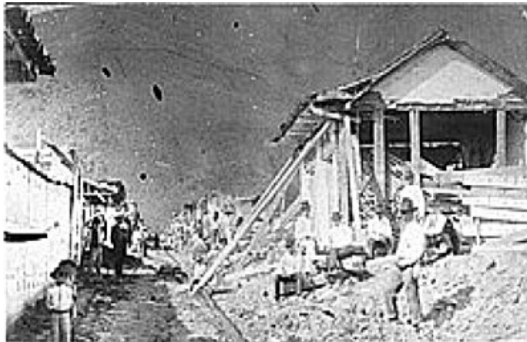
Fotografía 2. Muestra de los daños en los Andes, producto del sismo de 1894 (Fuente: G. Pilonieta, 2003).
